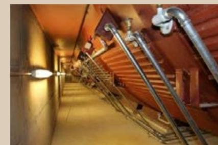
5. Ansicht Fermenter: Material verbleibt bei 50-55 Grad 21 Tage im Fermenter: Hier spricht man von einer „anaeroben thermophilen Trockenvergärung“
